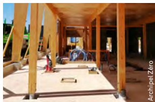
Plancher en panneaux de bois lamellé-croisé (CLT) sur le chantier du bâtiment Résilience à la Ferme des Possibles, à Stains.
