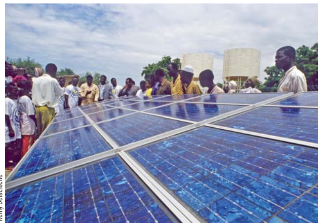
Regroupées sous la forme de modules, les cellules photovoltaïques produisent un courant électrique proportionnel à l'ensoleillement.
