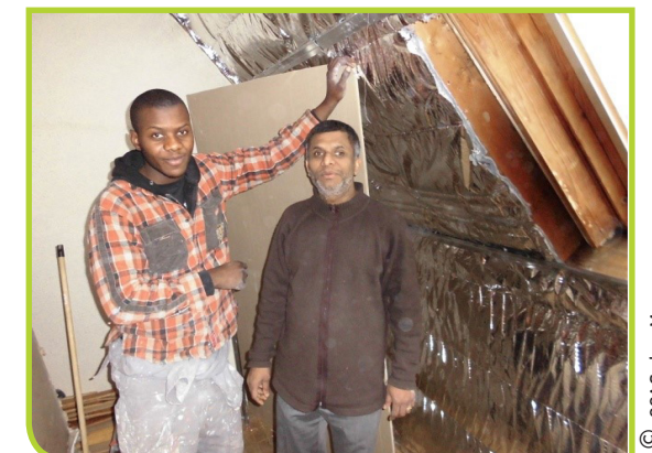
Isolation de combles en auto-réhabilitation accompagnée
