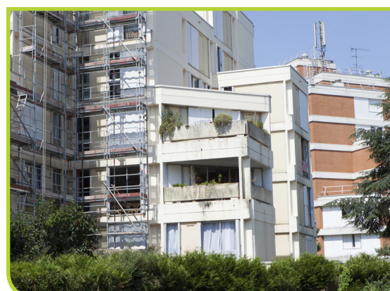
Rénovation énergétique dans une copropriété de Trappes
