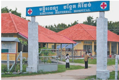
Système solaire pour la conservation des vaccins à l'hôpital de Kirivong, au Cambodge.
