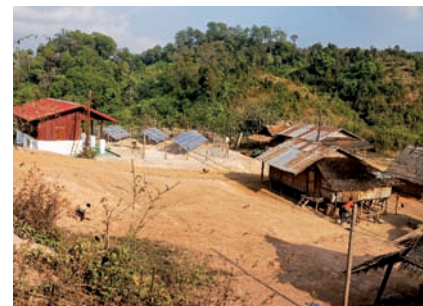
A Phakeo, au Laos, un système solaire remplace avantageusement l'utilisation d'un groupe électrogène. Il évite l'émission de CO2 et n'est pas bruyant.
